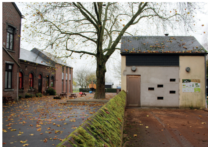
Depuis septembre 2019, quatre bâtiments de la commune d'Ottignies-Louvain-la-Neuve sont chauffés grâce à un réseau de chaleur à base de déchets verts.
